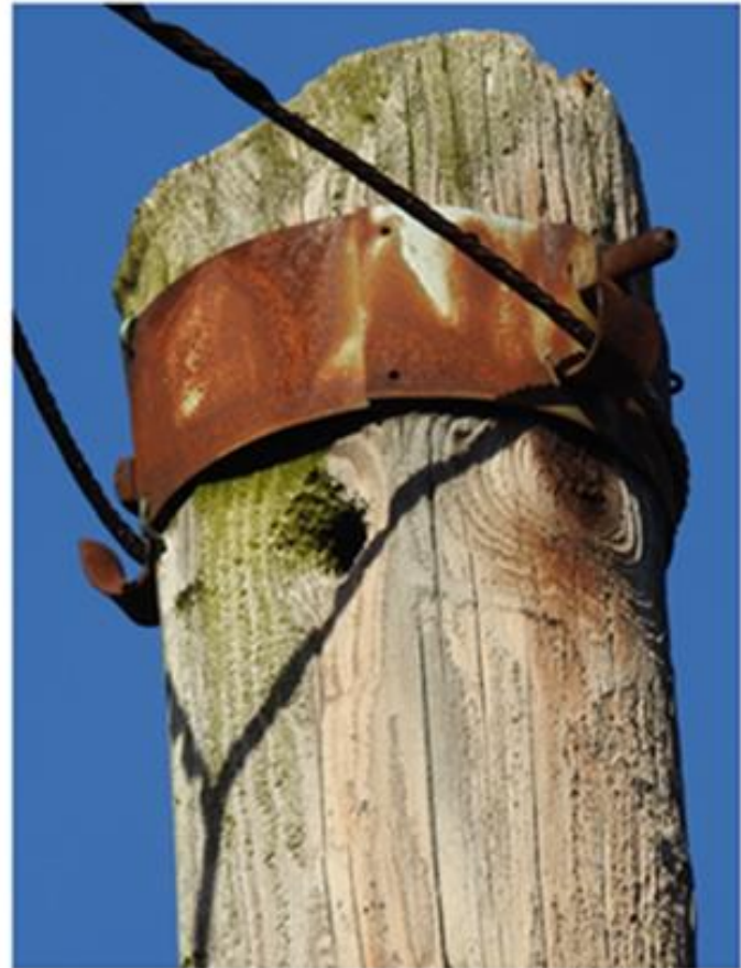
St. # 4571a Rotten pole tops
